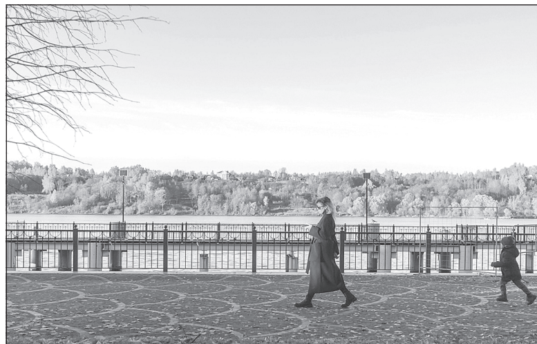
Летом продолжился капремонт набережной
