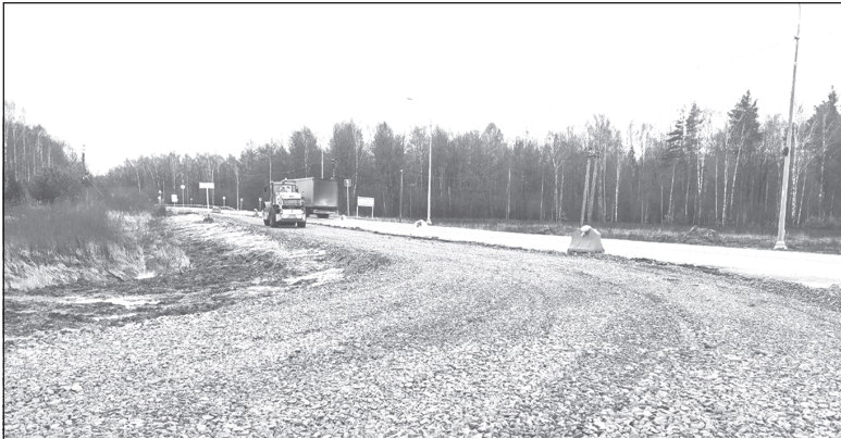
Ведутся работы по расширению дороги и ремонту водопропускных труб
